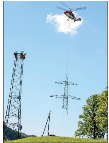
eingehalten werden. Insgesamt transportierte der Kamov 12,5 Tonnen Stahl. Die Montage der einzelnen Bauteile erfolgte durch Leitungsbaumonteur, die gemeinsam mit dem Piloten höchst präzise arbeiteten.
